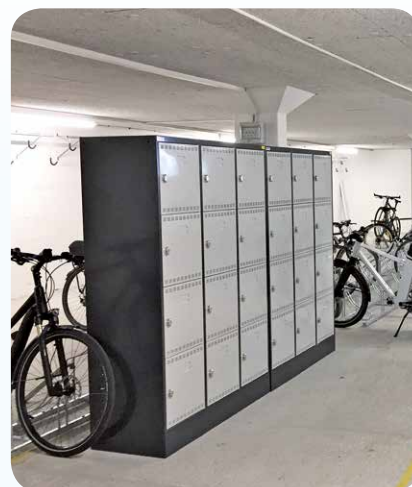
Armoire à casiers électrique comme station de recharge pour vélo électrique
