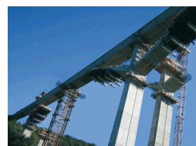
Génie civil, surveillance de la structure des ponts
