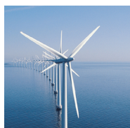
Secteur de l'énergie, contrôle permanent lors des installations offshore
